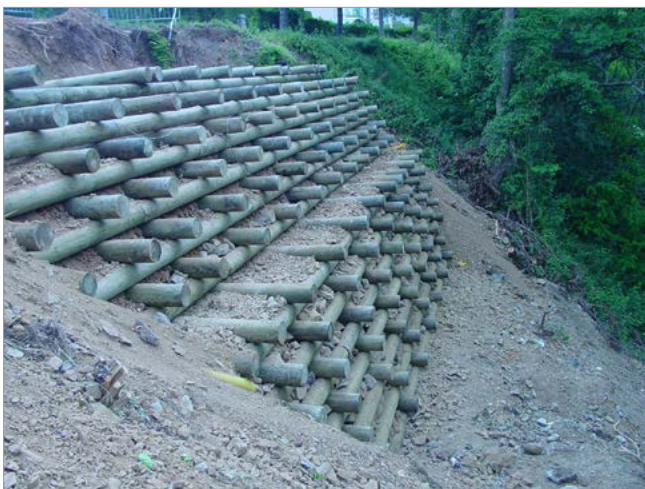
Arles-sur-Tech. Soutènement d'un talus en caisson bois (RTM, 2006)
