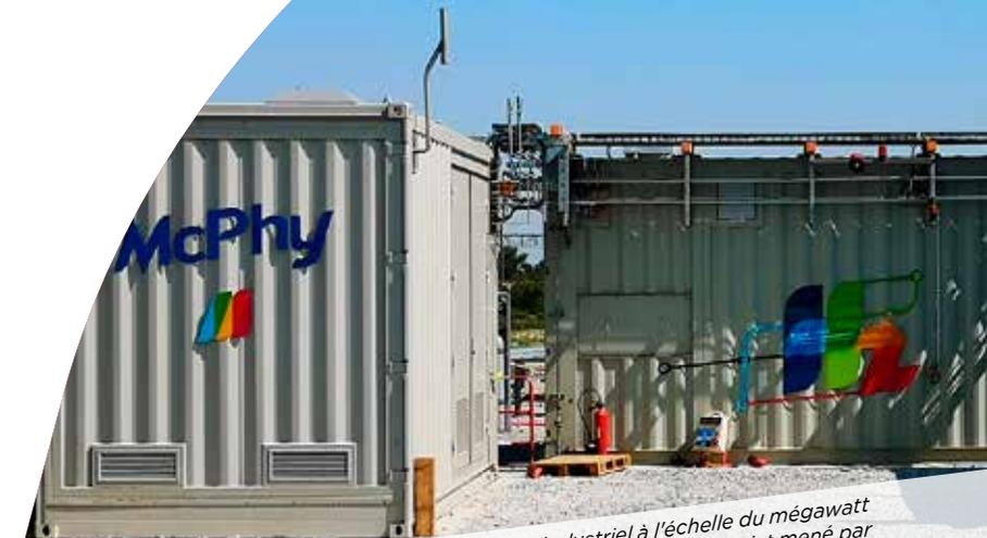
Jupiter 1000 | Power to Gas : premier démonstrateur industriel à l'échelle du mégawatt en France (0,5 MW électrolyse alcaline + 0,5 MW électrolyse PEM). Un projet mené par GRTgaz et impliquant de nombreux acteurs, dont McPhy pour la fourniture des électrolyseurs.
