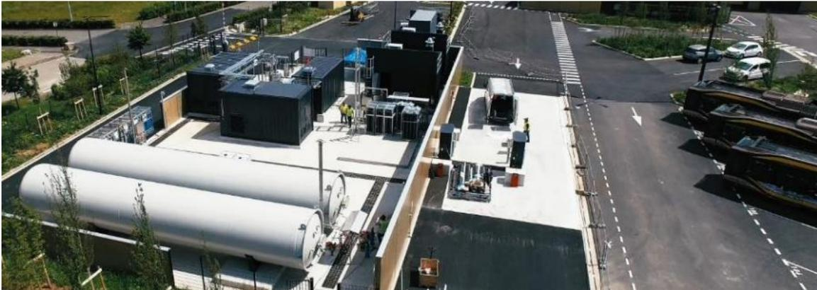
Haut de France, projet « SMT-AG » : première station hydrogène zéro-carbone pour bus en France (200 kg d'hydrogène / jour, 0,5 MW d'électrolyse).
